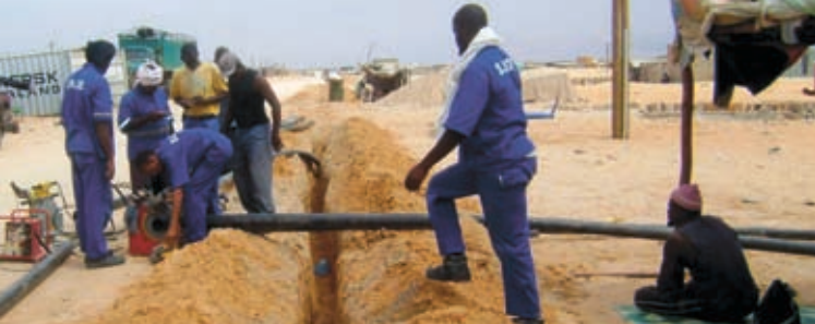
Pose de nouvelles conduites d'eau
