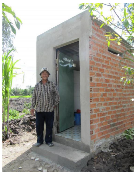
Begünstigter vor einer fertigen Latrine
