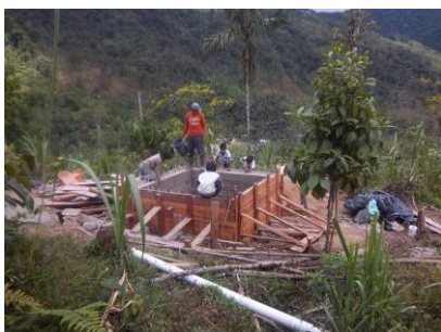
Una cisterna in costruzione
